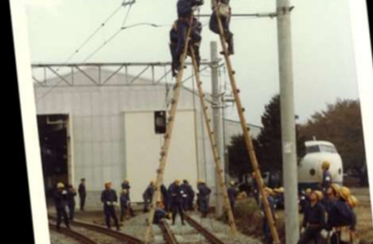
運転事故総合復旧訓練(昭和56年度)
