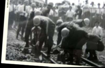
運転事故総合復旧訓練(昭和56年度)
