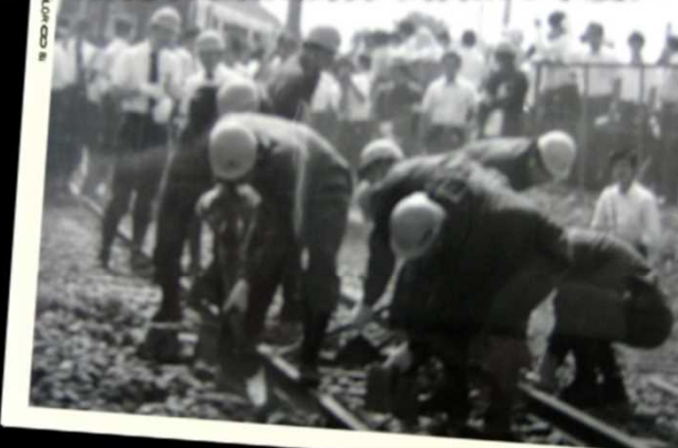
運転事故総合復旧訓練(昭和56年度)
